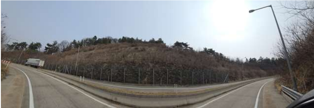
상주절토 07 (관리이정 도개IC R-A 0.070~0.330km / 2공구 도개IC R-A 0.070~0.330km)
